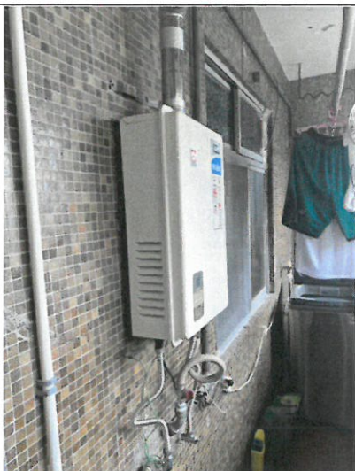
熱水器安裝在室外
