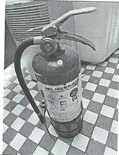
前陽台滅火器
