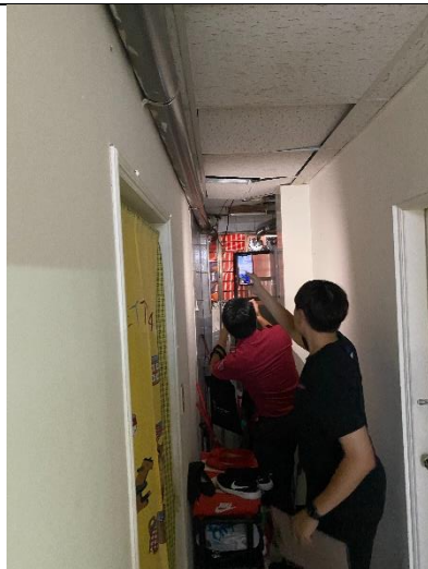
熱水器的強排管線
