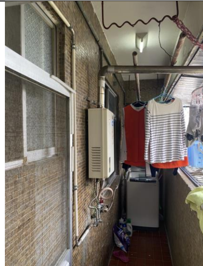
室外熱水器有強排管線
